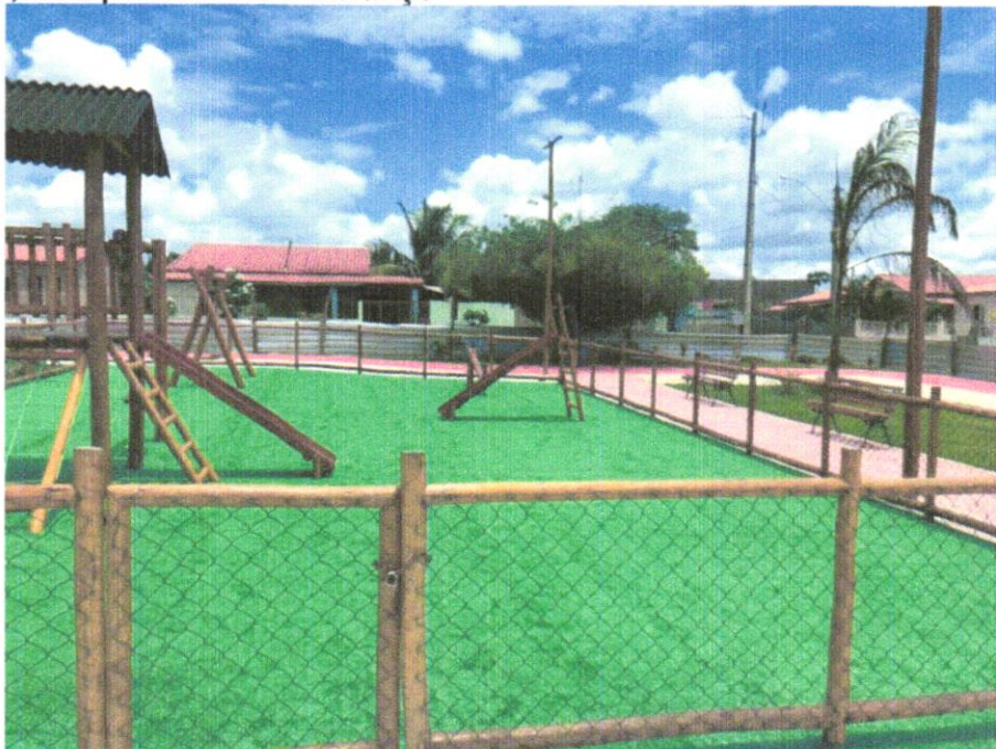
FOTO 08 – Fornecimento e assentamento de Escorregador em fibra com escada em eucalipto tratado, Fornecimento e assentamento de Balanço em eucalipto tratado e Fornecimento e assentamento de Gangorra em eucalipto tratado
